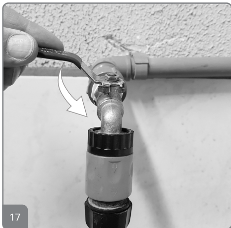
17. Abra a torneira ou o registro e deixe sair a água para retirar todo o ar da mangueira.
